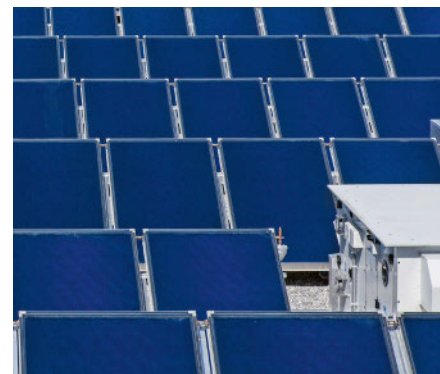
Diese thermische Solaranlage mit 316 Sonnenkollektoren von Ernst Schweizer AG (Hedingen) steht in der Wohnüberbauung Hochbord in Dübendorf und versorgt 226 Wohnungen mit Warmwasser.
