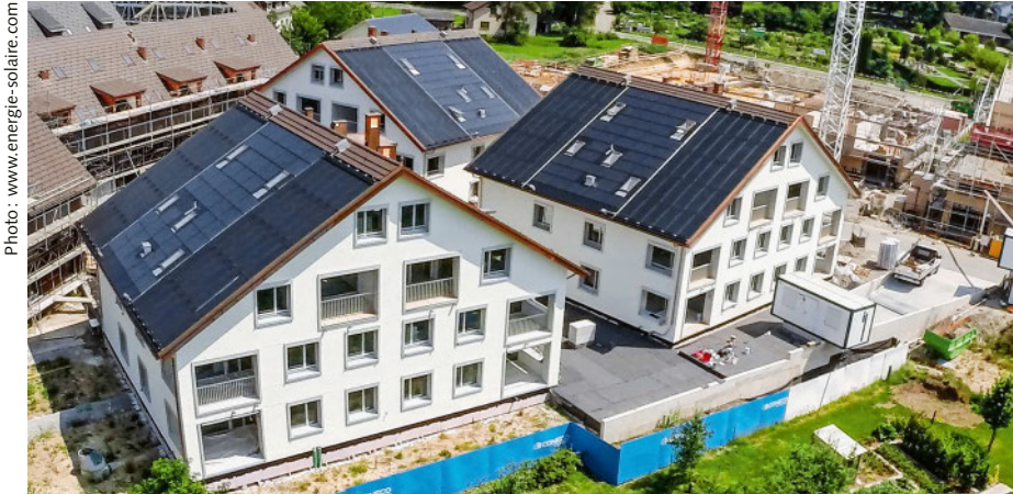
En 2016, l'entreprise énergie solaire (Sierra VS) a équipé trois immeubles (23 appartements) à Mettmenstetten de capteurs solaires (en bordure de toit) et de modules PV (au centre). En été, la chaleur excédentaire est injectée dans le sol pour la régénération des sondes géothermiques. Chaque maison dispose de capteurs thermiques non vitrés de 110 m 2 pour le domaine des basses températures. Ceci est nécessaire pour ne pas surchauffer le sol.
