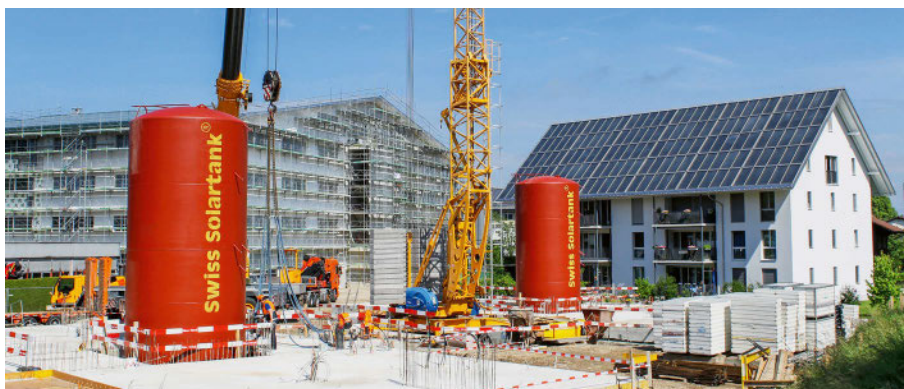
Un réservoir Swiss Solartank de Jenni Energietechnik (Burgdorf), d'une capacité de 108 000 litres, dans un immeuble de six appartements à Huttwil. Le réservoir de 10 mètres de long couvre 100 % de la demande en chaleur des résidents pour l'eau sanitaire et le chauffage.
