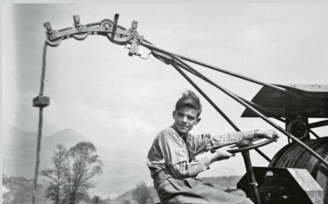
Über eine Führung war der Traktor mit einer Freileitung verbunden.
