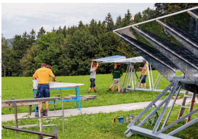
Die Module werden von den Installateuren zunächst am Boden zusammengebaut, bevor sie auf der fünf Meter hohen Stahlkonstruktion montiert werden.
