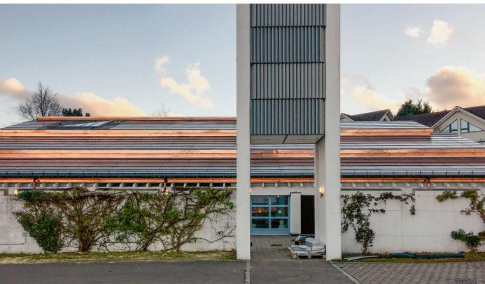
Die Röm.-Kath. Kirche St. Franziskus Ebmingen ist nach der energetischen Sanierung 2018/19 emissionsfrei. Dank verbesserter Dachdämmung, der Erdsonden-Wärmepumpe, der Solarwärmenutzung mit photovoltaisch-thermischen Modulen und der LED-Beleuchtung konnte der bisherige Gesamtenergiebedarf um rund 35% auf jährlich 54 700 kWh reduziert werden.
