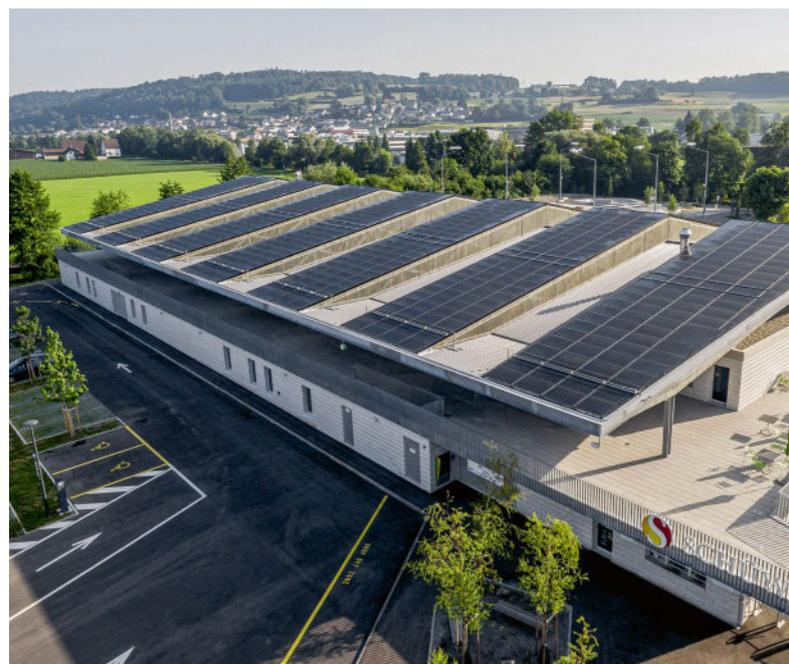
Die 0,38 MW starke PV-Dachanlage auf der Eishalle des Schüwo Parks in Wohlen im Kanton Aargau ist gut integriert und liefert Solarstrom. Fenster und Lichtbänder sorgen für Tageslicht im Gebäudeinneren. Dadurch spart die Eishalle Beleuchtungskosten und Energie.
