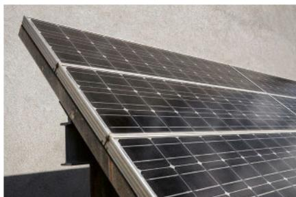
Die Anlage besteht aus 72 Modulen des Typs M55 Siemens Monokristall.
