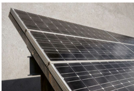
L'installation est composée de 72 modules monocristallins M55 Siemens.
