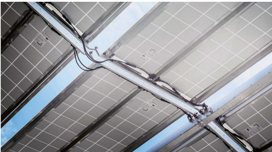
Die leichten Photovoltaikmodule des «Horizon»-Solarfaltdachs sind beweglich miteinander verbunden, sodass sie sich horizontal auseinander- und vertikal zusammenfalten lassen. Die Kabel transportieren den Sonnenstrom.
