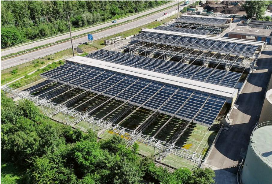
Die Pionieranlage des Solarfaltdachs (das hier gerade ausfährt) ist seit Mitte 2018 in der ARA Chur im Vollbetrieb. Die Kläranlage deckt mit dem produzierten Sonnenstrom (540 000 kWh/Jahr) 20 Prozent ihres Eigenstrombedarfs ab. Dies entspricht den Erwartungen der verantwortlichen IBC Energie Wasser Chur.
