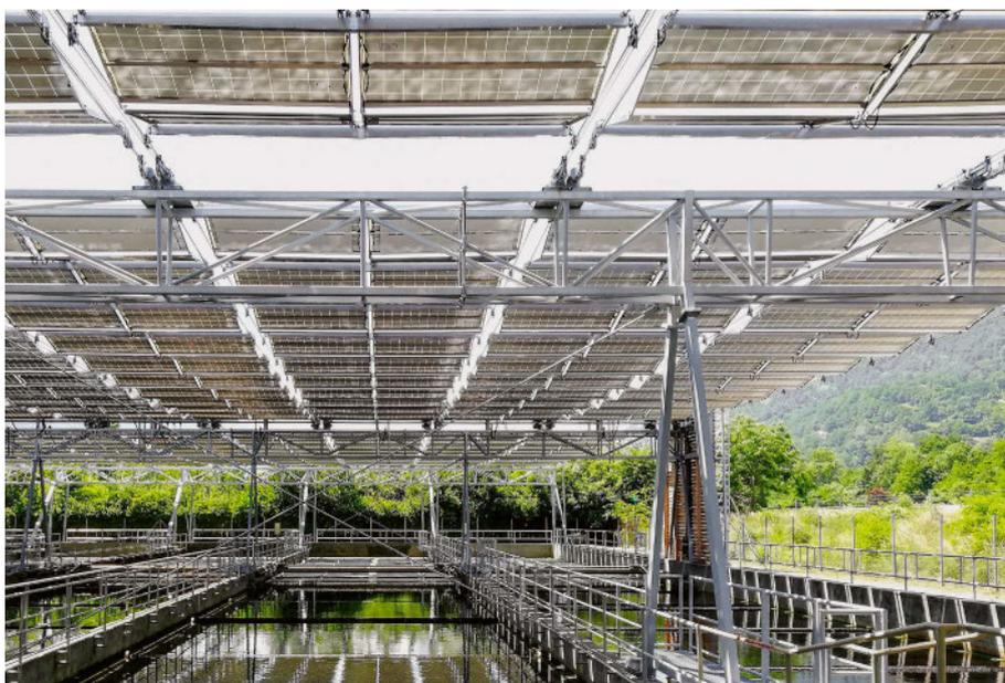
Die luftige Konstruktion an Tragseilen ist kompatibel mit dem Betrieb in Abwasserreinigungsanlagen (ARA). Für diese stromintensiven Infrastruktureinrichtungen ist die Stromproduktion vor Ort attraktiv. Nach den Erfahrungen in Chur haben die Verantwortlichen der ARA von Flums, Bassersdorf, Münsterlingen, Romanshorn und Bilten ebenfalls in Solarfaltdächer investiert.
