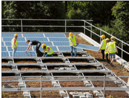
Ecolières construisant le toit solaire au lycée DeLu, Derendingen
