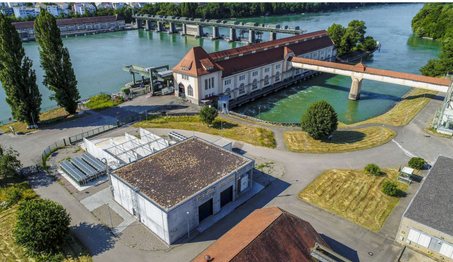
Die industrielle Power-to-Gas-Anlage am Wasserkraftwerk in Grenzach-Wyhlen gegenüber Kaiseraugst am Rhein produziert zuverlässig Wasserstoff.
