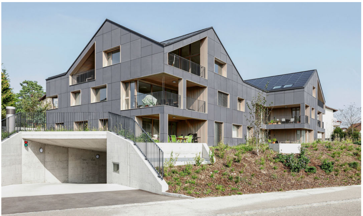
Le premier immeuble résidentiel entièrement autonome en énergie de Brütten (ZH) peut se passer d'alimentation en énergie externe toute l'année, en partie grâce à un système intégré d'hydrogène. L'électricité excédentaire produite par les panneaux solaires est convertie en hydrogène, stockée et reconvertie en électricité lorsque cela est nécessaire. Un projet de l'Umwelt Arena Schweiz en collaboration avec René Schmid Architekten AG.
