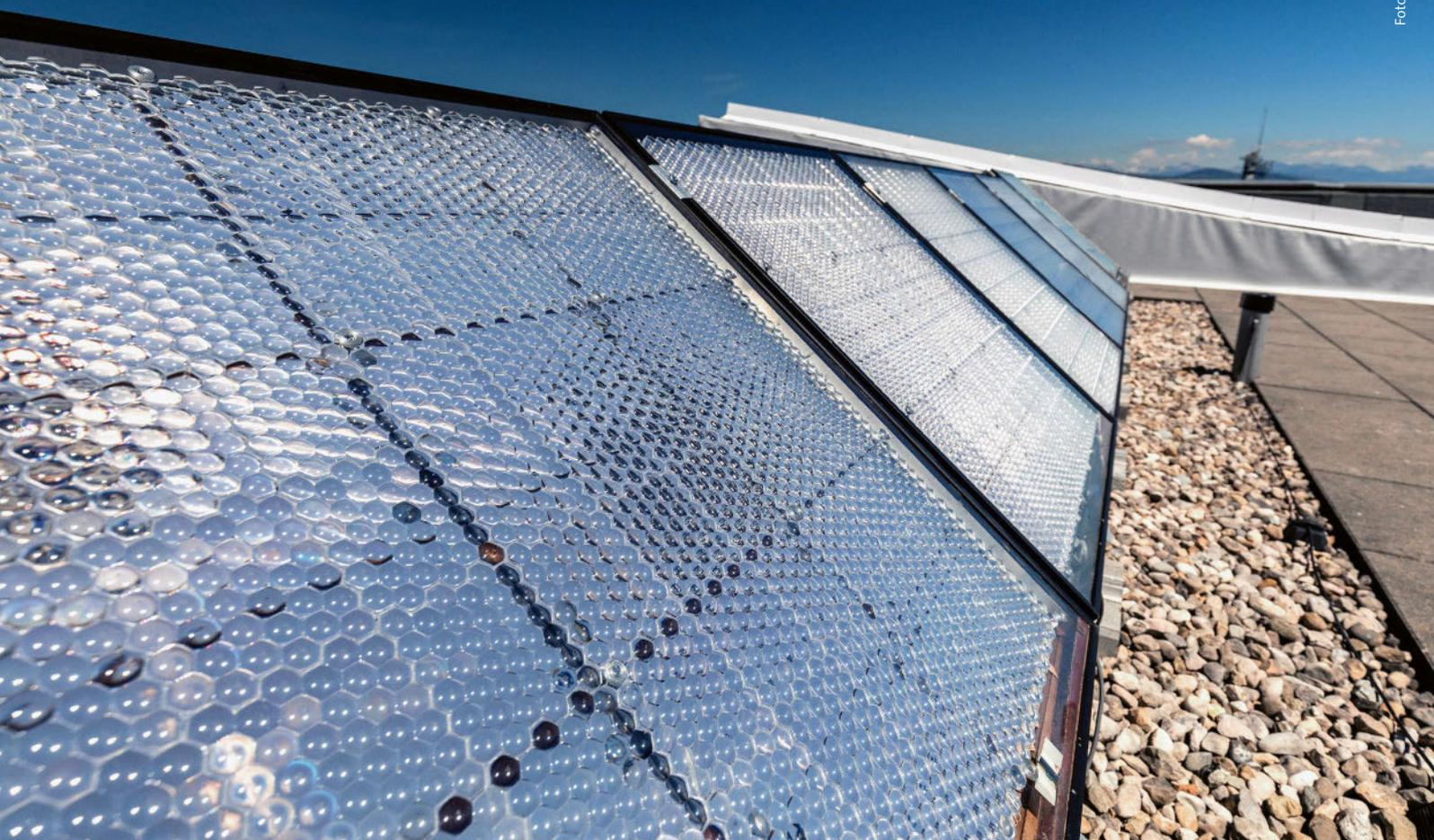
die Oberflächen der Linsen (vgl. Grafik unten). Die Herstellung eines CPV-Solarmoduls braucht viel weniger Halbleitermaterial, was die Nutzung von Hochleistungszellen bei akzeptablen Stromgestehungskosten erlaubt. Voraussetzung für den Einsatz von CPV ist ein genügend hoher Anteil an direkter Einstrahlung.
