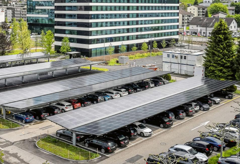
Die Solarstromerzeugung der Carports Schindler von jährlich 310 000 kWh Solarstrom kann zu 100% auf dem Areal genutzt werden.
