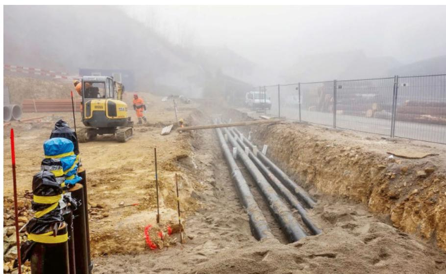
Durch diese Rohrleitungen gelangt das heisse Wasser aus dem Holzheizwerk in den Wärmeverbund BéroCAD.
