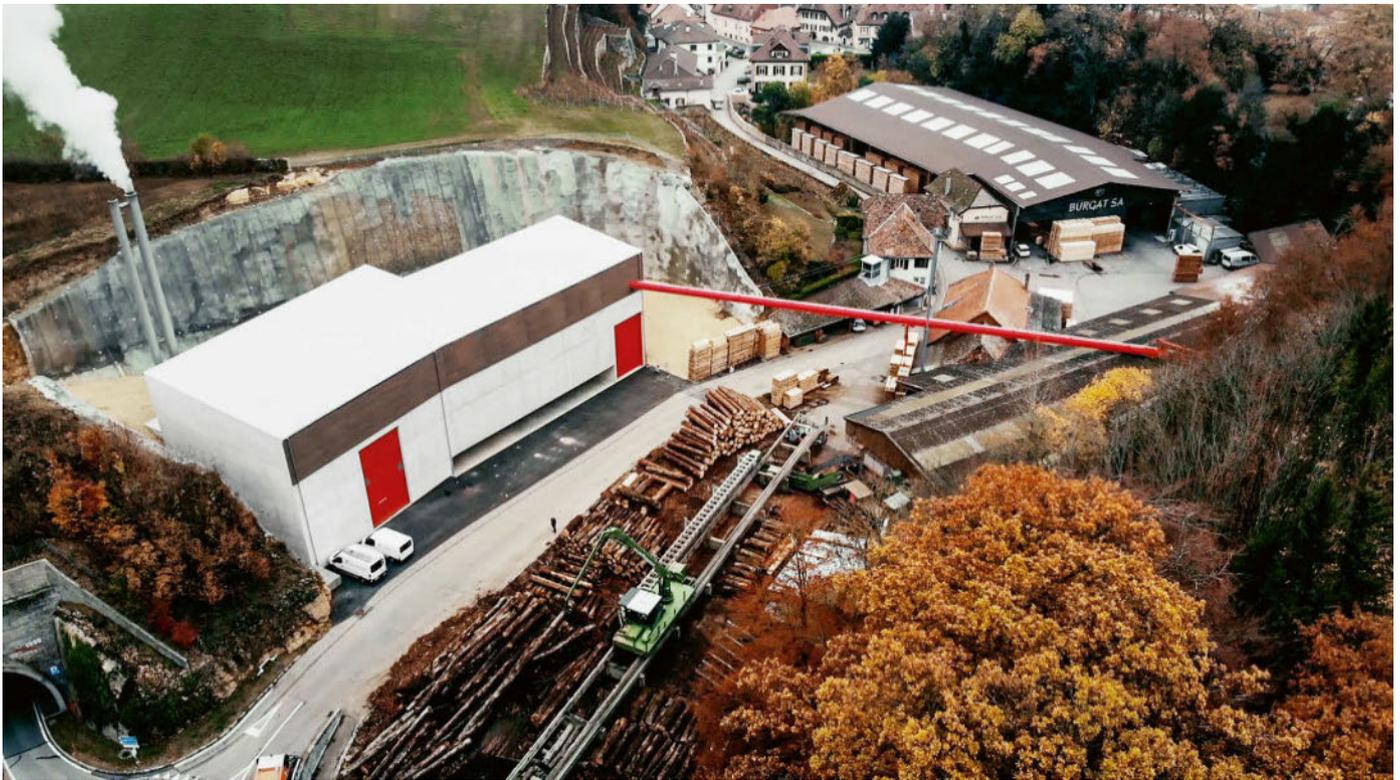
Ein Hängeförderband transportiert die Hack-schnitzel vom Sägewerk zum Holzheizwerk (links im Bild).
