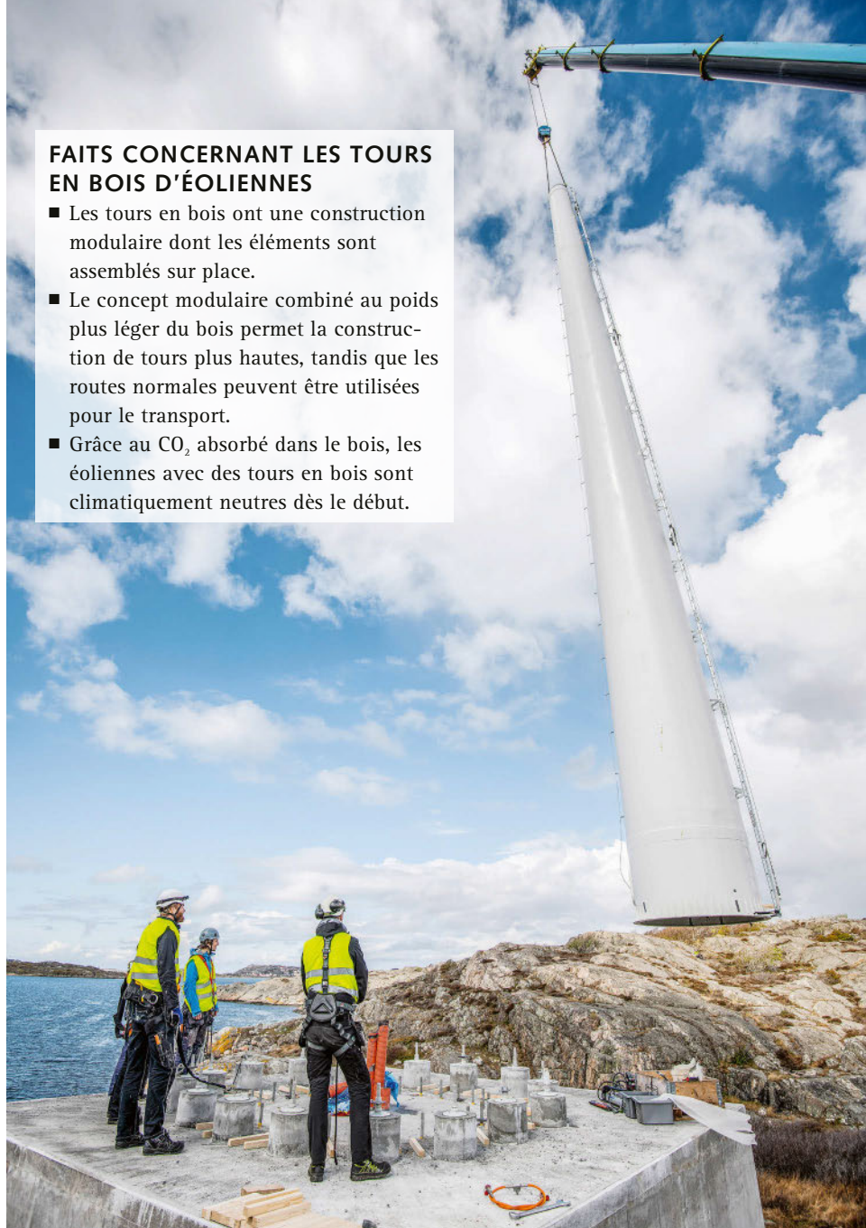
La première tour éolienne en bois est installée depuis près d'un an en Suède, sur l'île de Björkö au large de Göteborg.
