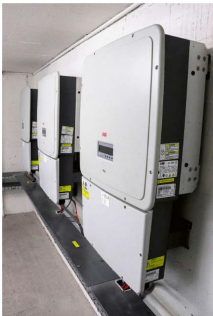
**Die Wechselrichter bei Camille Bloch in Courtelary erzeugen Wechselstrom. Jeder Wechselrichter hat eine Leistung von 27,6 kW bzw. von 20 kW. Die Gesamtleistung der insgesamt zehn Wechselrichter liegt bei 260 kW. Die Umrichter können zur Kompensation von Blindleistung herangezogen werden.**
