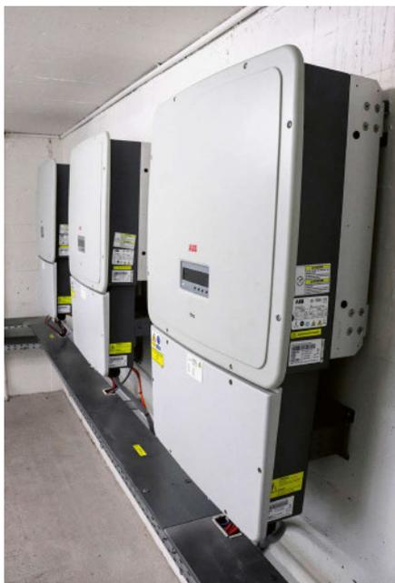
**Les onduleurs de Camille Bloch à Courtelary produisent du courant alternatif. Chaque onduleur a une capacité de 27,6 kW et 20 kW respectivement. La capacité totale des dix onduleurs est de 260 kW. Les onduleurs peuvent être utilisés pour compenser la puissance réactive.**
