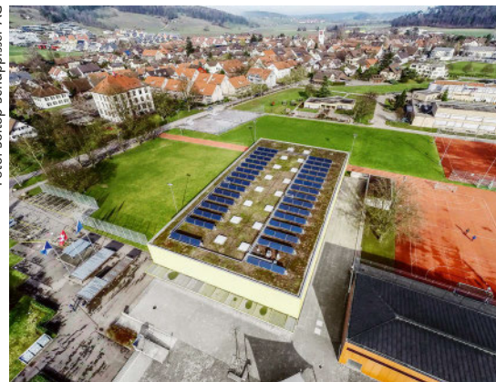
Sonnenkollektoren auf der Turnhalle in Neftenbach liefern Solarwärme für den Holzwärmeverbund Ebni.
