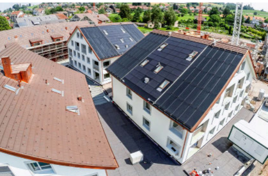
Mit Solarwärme die Erdsonden regenerieren ist eine Möglichkeit, sommerliche Wärme saisonal zu speichern, wie hier in einer Überbauung in Mettmenstetten.
