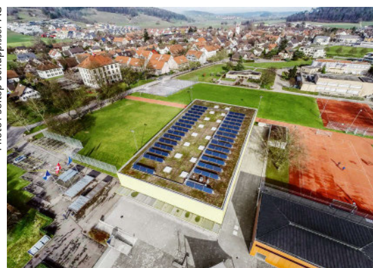
Les capteurs solaires du gymnase de Neftenbach alimentent en chaleur solaire le réseau de chauffage au bois Ebni.
