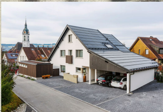
Die neue ins Dach integrierte 39,5-kW-Nord-Süd-PV-Anlage auf dem 1989 erbauten PlusEnergie-Dreigenerationenhaus in Sempach (LU) erzeugt 32 000 kWh/a.
