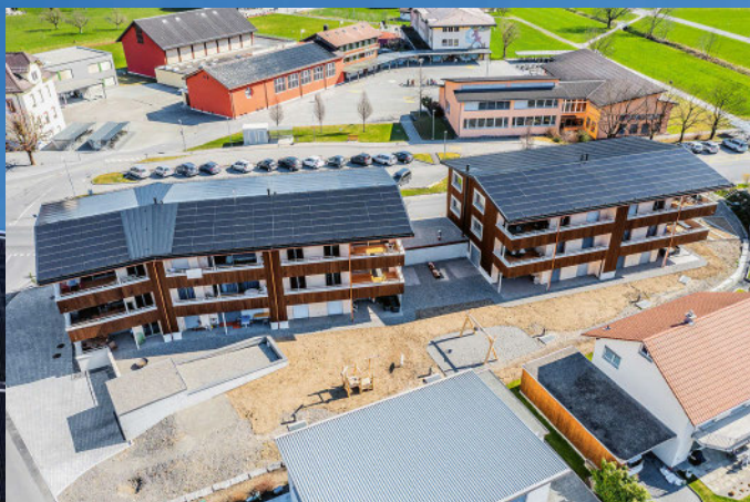
Die zwei MFH «Sunnäplätzli» in Giswil (OW) mit insgesamt 15 Wohnungen sind optisch ansprechend und nachhaltig gebaut. Die 138 kW starke PV-Anlage auf den Dächern erzeugt jährlich 142 800 kWh Strom.
