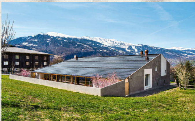
Mit der Erweiterung und Sanierung ist aus dem 1975 erbauten Mehrzweckgebäude von Fläsch (GR) ein architektonisches und energetisches Bijou geworden. Auf das vergrösserte Dach wurde eine nach Osten und eine nach Westen ausgerichtete vorbildlich integrierte 174 kW starke PV-Anlage installiert.
