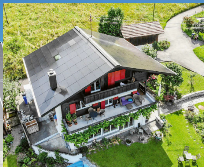
Das 1953 erbaute EFH der Familie Erni in Thun (BE) wurde 2020 energetisch beispielhaft saniert. Die vorbildlich integrierte 18,6-kW-PV-Dachanlage erzeugt 17 900 kWh/a, sichert 238 % des gesamten Energiebedarfs und eliminiert die 17,3 t CO 2 -Gebäudeemissionen auf null.
