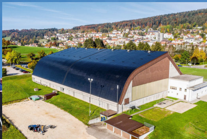
Der Comptoir de Tramelan beherbergt die Eisbahn, ein Restaurant, Umkleieräume und einen Zivilschutzraum. Die 411 kW starke PV-Anlage auf dem gebogenen Dach erzeugt 435 000 kWh/a und deckt damit 104 % des Energiebedarfs.
