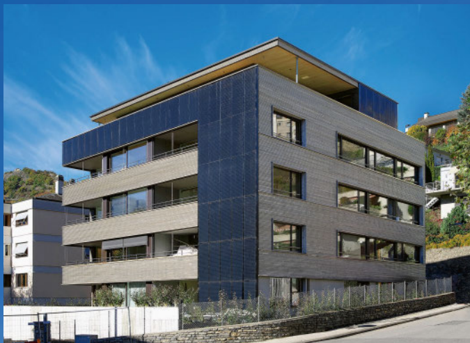
Das 2020 erstellte architektonisch sehr ansprechende Mehrfamilienhaus Sakura in Sion (VS) umfasst neun Wohnungen. Die nach Osten und nach Westen integrierte 27,3-kW-PV-Dachanlage erzeugt rund 32 500 kWh/a, und die südseitig integrierte solarthermische Fassadenanlage zur Heizungsunterstützung produziert 21 000 kWh/a.
