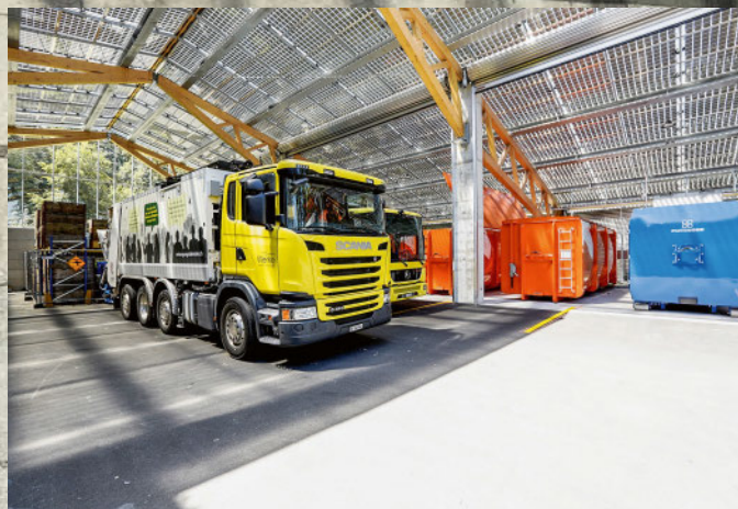
Die Werke der Stadt Wädenswil (ZH) wurden 2019 vorbildlich saniert und erweitert. Im Rahmen dieser Sanierung entstand ein neues Solardach mit einer ganzflächig integrierten 140 kW starken PV-Anlage.
