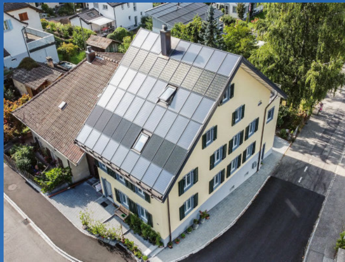
Das über 200-jährige Einfamilienhaus in Windisch (AG) wurde 2020 saniert. Die 7,5 kW starke PV-Anlage erzeugt jährlich 7400 kWh. Die solarthermische Anlage mit einer Fläche von 55 m 2 erzeugt 19 250 kWh/a.
