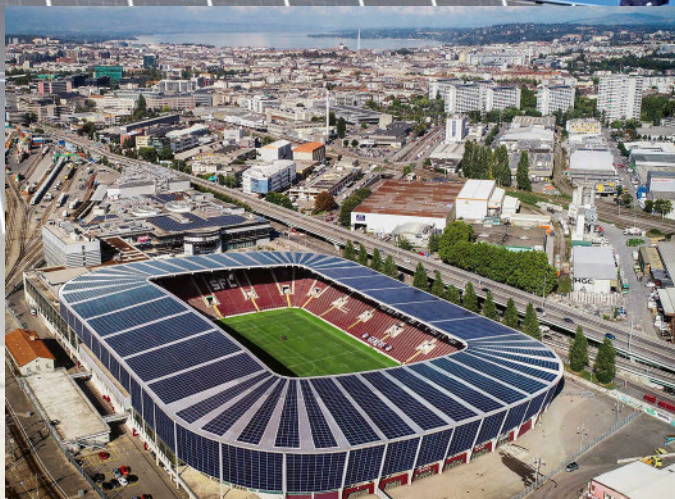
Das erste Fussballstadion errichtete die Stadt Genf 1930 in Servette. Ende des 20. Jahrhunderts wurde das neue Stadion in La Praille realisiert. 2019 fand eine Stadionsanierung statt, und es wurde eine 942 kW/a starke PV-Anlage installiert.
