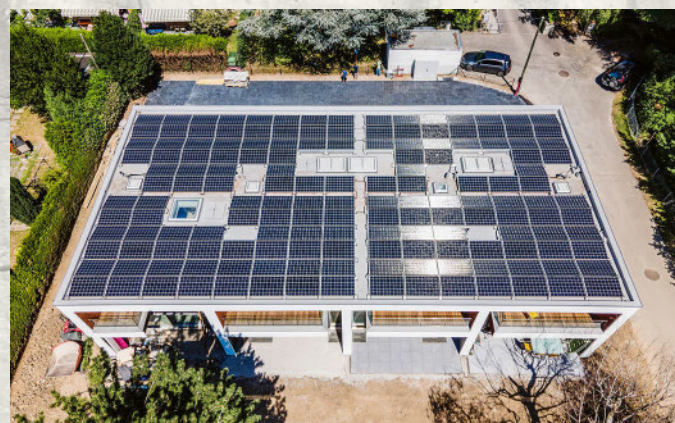
Die 2020 zusammengebauten vier Minergie-P-Wohnhäuser in Thônex (GE) benötigen insgesamt 27 600 kWh pro Jahr. Die nach Osten und nach Westen ausgerichtete 50,7-kW-PV-Dachanlage produziert 43 300 kWh/a CO 2 -freien Solarstrom.
