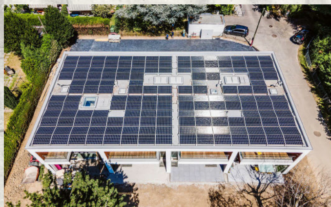
Construites à Thônex (GE) en 2020, les quatre villas contiguës au standard Minergie-P consomment ensemble 27 600 kWh/a. Sur les toits, l'installation PV de 50,7 kW orientée est-ouest génère 43 300 kWh/a, soit une autoproduction de 157 %.
