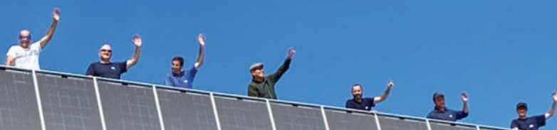
Construit en 2020 et abritant neuf appartements, l'immeuble Sakura, à Sion (VS), se distingue par son architecture très attrayante. Sur le toit, l'installation PV de 27,3 kW orientée est-ouest génère 32 500 kWh/a.
