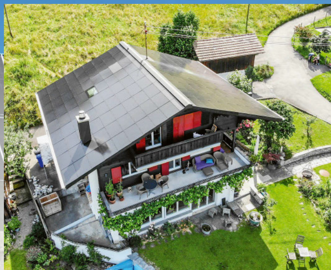
Construite en 1953 à Thonon (BE), la villa de la famille Erni a été énergétiquement assainie en 2020. Bien intégrée au toit, l'installation PV de 18,6 kWc génère 17 900 kWh/a, assurant ainsi une autoproduction de 238 %.
