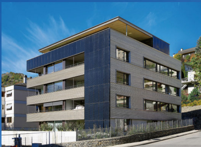
Construit en 2020 et abritant neuf appartements, l'immeuble Sakura, à Sion (VS), se distingue par son architecture très attrayante. Sur le toit, l'installation PV de 27,3 kW orientée est-ouest génère 32 500 kWh/a.
