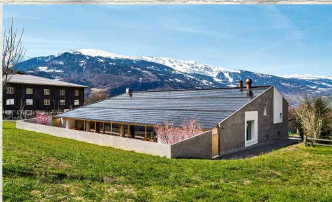
Construit en 1975, le bâtiment polyvalent à Fläsch consommait 60 300 kWh/a avant rénovation. Bien intégrée à toute la toiture, l'installation PV de 174 kW est orientée est-ouest et génère 179 700 kWh/a. Elle assure une autoproduction de 275 % et évite le rejet de 96,1 t d'émissions de CO 2 .
