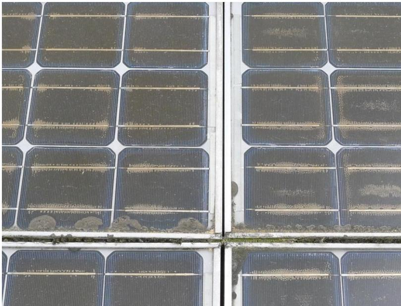
Unterste Zellreihe durch Verschmutzung, resp. Biofilm teilweise abgedeckt. Dies vermindert den Ertrag der Anlage. Bei wenig geneigten Anlagen und gerahmten Modulen tritt dies früher auf. Je nach Situation Reinigung nach ein paar Jahren prüfen. Bei Flachdächern Pflanzenbewuchs jährlich (z.B. im Frühsommer) entfernen, insbesondere verholzenden Bewuchs.
