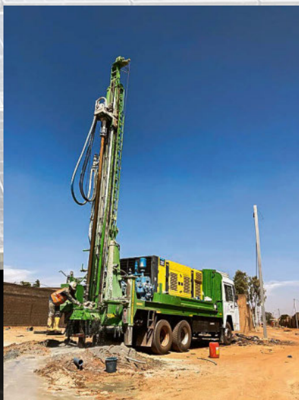
Die Brunnen-Bohr-Lastwagen von Solafrique bohren ständig neue Brunnen.
