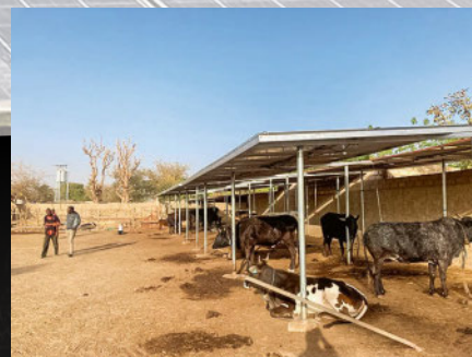
So sieht eine fertige Wasserversorgungsstation (hinten) mit einem zugehörigen Solar-Minigrid aus.
