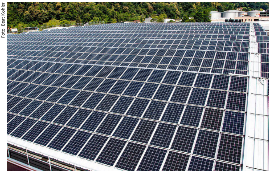
Es ist günstiger, eine überdimensionierte Fläche mit Photovoltaik zu belegen, als grosse Speicher für den Solarstrom zu bauen.
