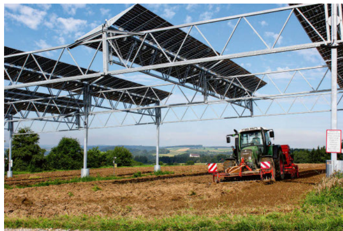
Agri-PV-Pilotanlage des Fraunhofer ISE in Heggelbach im Allgäu. Die Solarmodule sind so hoch angebracht, dass der Traktor für die Aussaat unten durchfahren kann.
