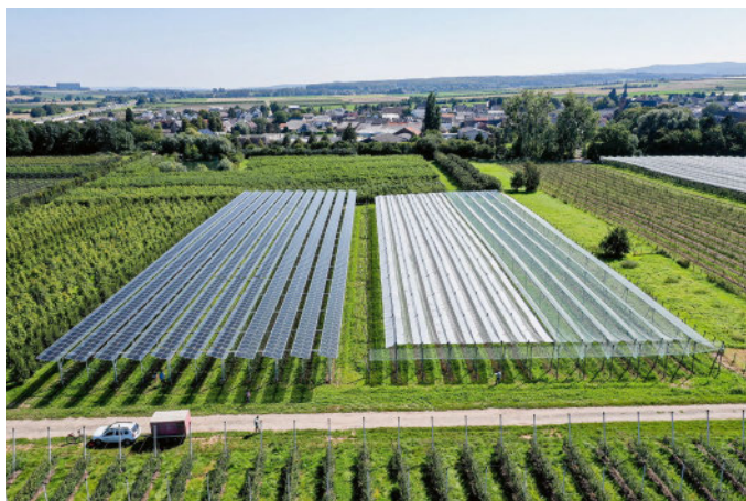
Agri-PV-Anlage bei einer Obstkultur in Gelsdorf im deutschen Rheinland. Bauern können sich mit der Produktion von Solarstrom eine neue Einnahmequelle erschliessen. Solarmodule haben für die Pflanzen eine Schutzwirkung, vermindern mitunter aber auch die Erträge, wie Studien zeigen.
