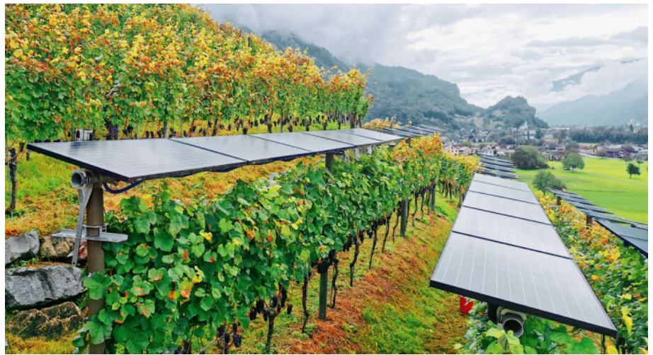
Agri-PV wird in der Schweiz erst in Ansätzen praktiziert: Bild einer privat initiierten Anlage über einem Rebberg in Walenstadt. Die Pflanzen unter den Solarmodulen sind weniger stark von Blattkrankheiten befallen. Da die PV-Module genügend hoch über den Pflanzen angebracht sind, hat die Stromproduktion in diesem Fall keine Ertragseinbussen zur Folge.
