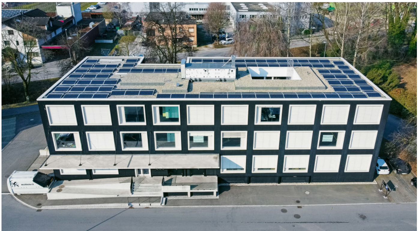
NeoVac hat das Gebäude der Walbusch Walter Busch AG fit gemacht in Sachen Energieeffizienz.
