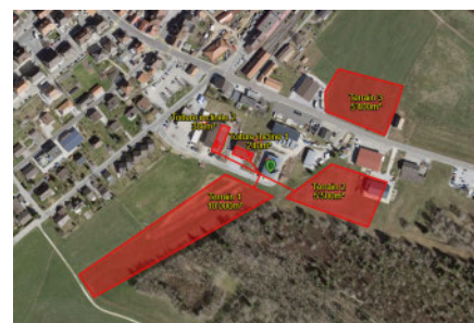
Rot markiert sind die Dach- und Agrarflächen, die im Neuenburger Dorf Ponts-de-Martel für den Bau einer grossen Solarthermieanlage zu Studienzwecken in Erwägung gezogen wurden. Neben der Heizzentrale (grünes Symbol) kommen zwei Dächer mit insgesamt 620 m 2 und Landflächen mit 20900 m 2 infrage. Letztere bieten Platz für 8400 m 2 Solarkollektoren. Damit der lokale Wärmeverbund die Sommermonate Juli und August allein mit Solarthermie bestreiten kann, wären gemäss den Simulationsergebnissen 1800 m 2 Kollektoren nötig.
