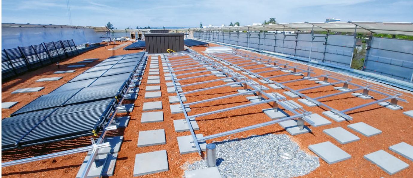
Solarkollektoren der Überbauung Weltpostpark während der Montage.
