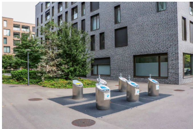
Weil der Platz im Erdreich knapp war, wurde Haus B der Berner Weltpostpark-Überbauung nicht mit einem grossen, sondern mit zwei kleinen Eisspeichern ausgerüstet. Einer von ihnen befindet sich im Erdreich unter der Grünfläche hinter den sechs Mülleimern.
