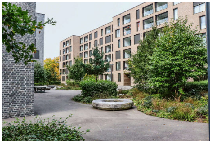
Die Überbauung Weltpostpark in Bern besteht aus drei Mehrfamilienhäusern mit einer Bruttogeschossfläche von 19 800 m 2 und einer Energiebezugsfläche von 14 500 m 2 . Unter der kreisrunden Sitzbank befindet sich einer der vier Eisspeicher.
