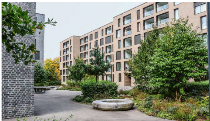
Le lotissement Weltpostpark à Berne se compose de trois immeubles résidentiels d'une surface brute de plancher de 19 800 m 2 et d'une surface de référence énergétique de 14 500 m 2 . Sous la banquette circulaire se trouve un des quatre accumulateurs de glace.
