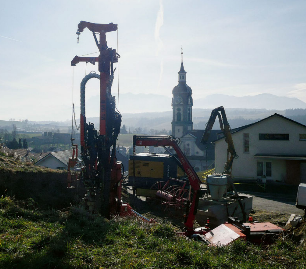
Pose de sondes géothermiques à Ruswil (LU)
