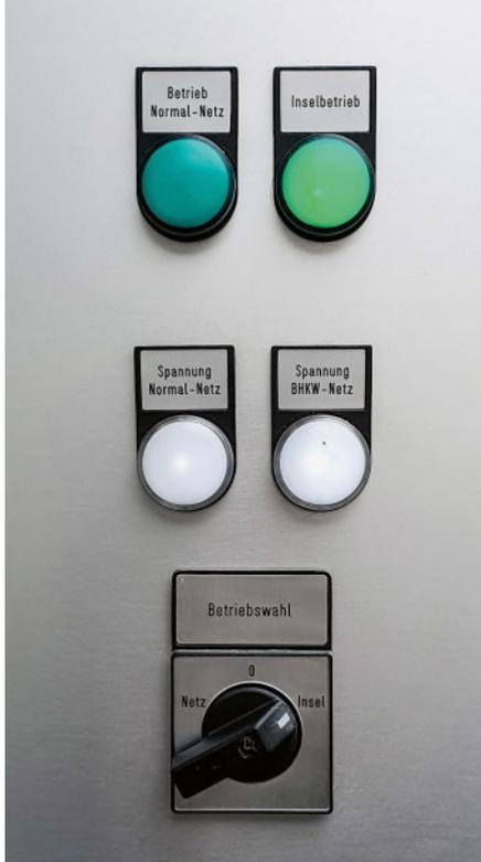
Um ein Inselnetz zu etablieren, muss dieses über einen Netztrennschalter (Bild) vom allgemeinen Stromnetz getrennt werden.
