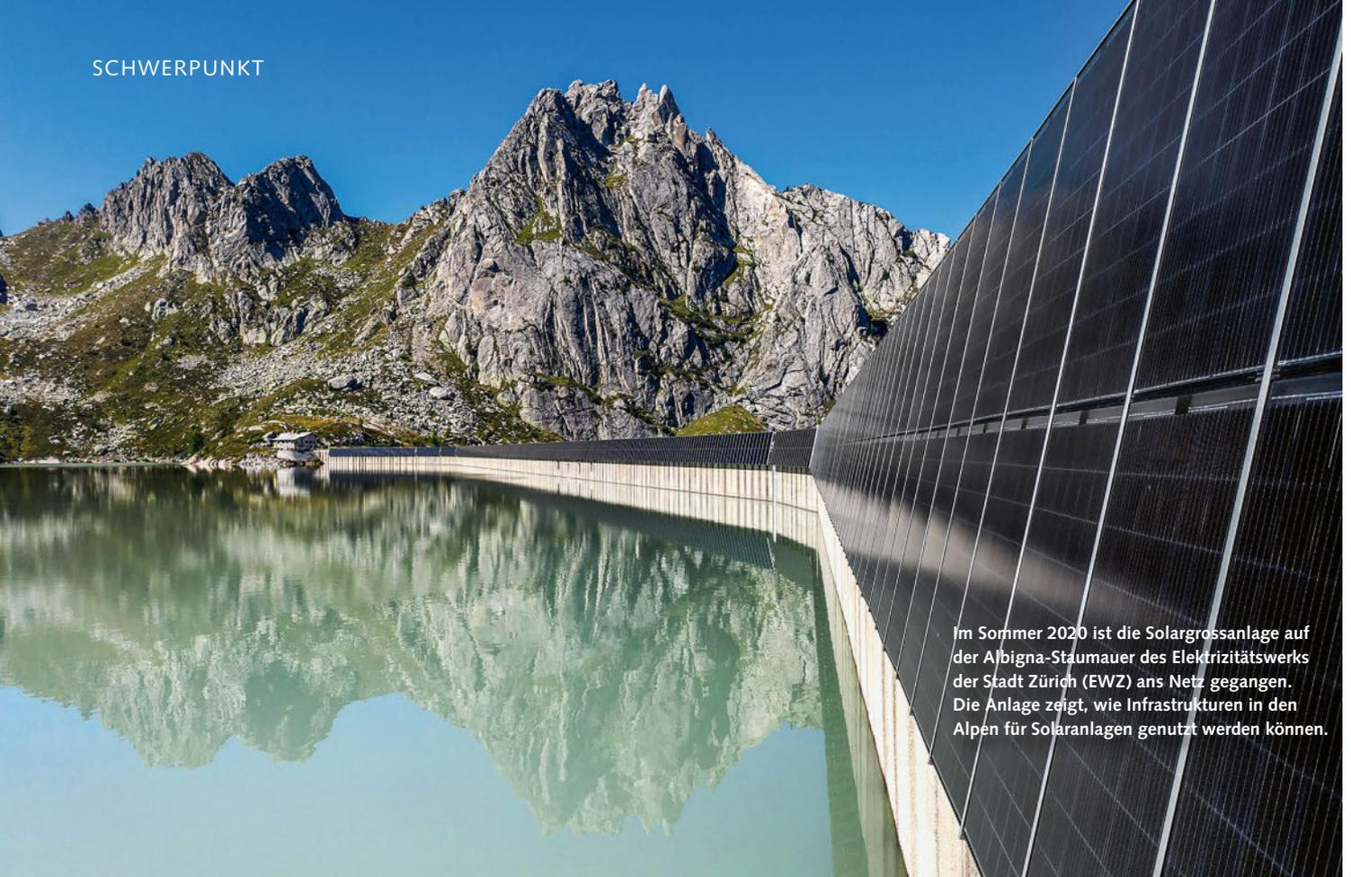
Im Sommer 2020 ist die Solargrossanlage auf der Albigna-Staumauer des Elektrizitätswerks der Stadt Zürich (EWZ) ans Netz gegangen. Die Anlage zeigt, wie Infrastrukturen in den Alpen für Solaranlagen genutzt werden können.
