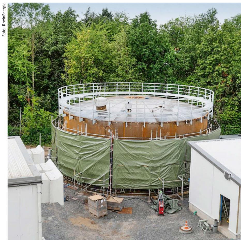
RheinEnergie baut einen neuen Fernwärmespeicher. Der Speicher wird das Heizwasser aus dem Heizkraftwerk bei Bedarf aufnehmen und es flexibel ins Fernwärmenetz abgeben.
