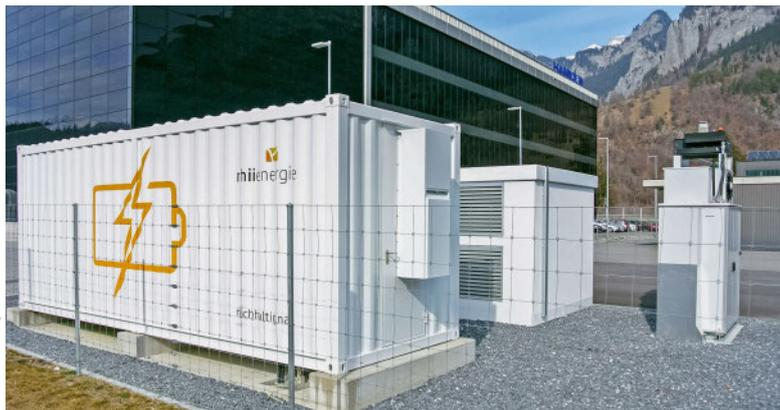
Seit 2021 ist in der Schweiz ein Grossspeicher mit 1,25 MW Leistung und 1,3 MWh Kapazität für die Rhienergie AG in Graubünden in Betrieb. Der 7,5 Meter lange Container steht direkt vor dem Unterwerk Vial in Domat/Ems. Die Investition in die Grossbatterie hat sich gelohnt, denn sie hat sich nach zwei Jahren bereits amortisiert. Rhienergie ist begeistert von der Leistungsfähigkeit und Zuverlässigkeit der Anlage. Das Unternehmen plant nun ein weiteres, deutlich grösseres Batteriekraftwerk.
