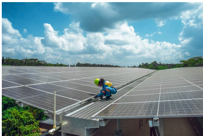
Bild 4: Montage der Solarmodule
