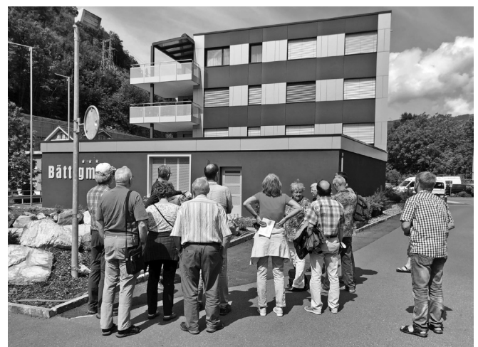
Blick auf die PV-Fassade des stromnetzunabhängigen Mehrfamilienhauses Bättigatt
