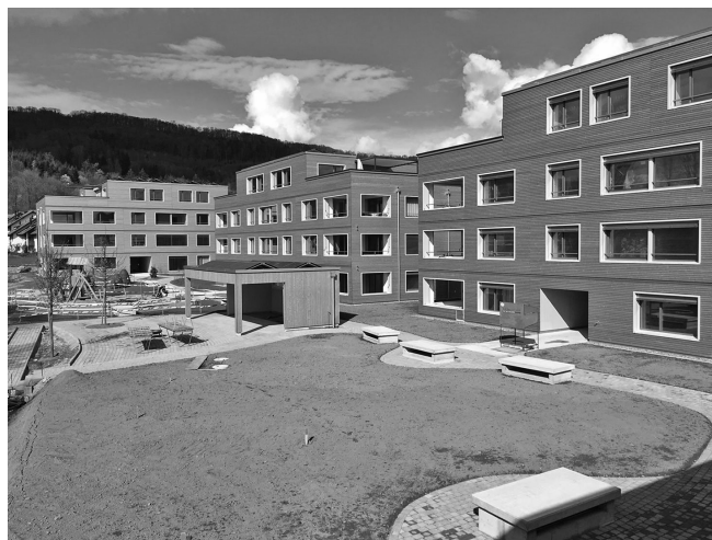
Arealüberbauung mit Eigenverbrauchsoptimierung in Möriken Foto: Setz Architektur AG
