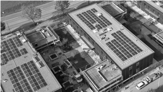
96 kWp auf Neubauten der Stiftung MBF in Stein
