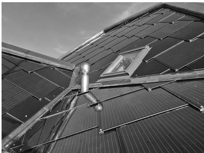
Haus Kühni: Perfekte Indach PV-Anlage
