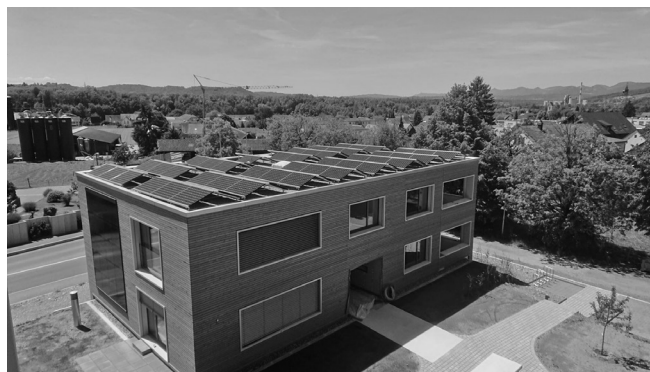
Plusenergie-Mehrfamilienhaus in Möriken Foto: Setz Architektur AG
