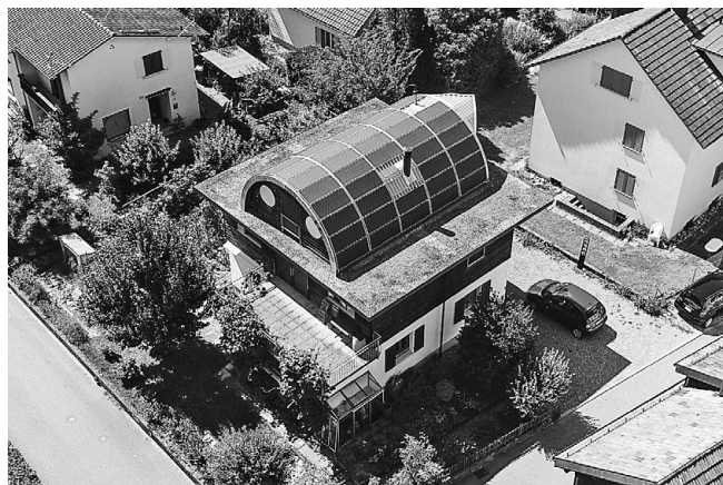
Haus Candina mit PV-Tonnendach an der Lindhofstrasse 38
