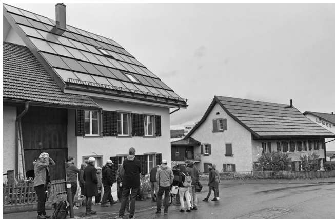
Thermische Sonnenkollektoren (links) und PV-Anlage (rechts) an der Dorfstrasse in Windisch
