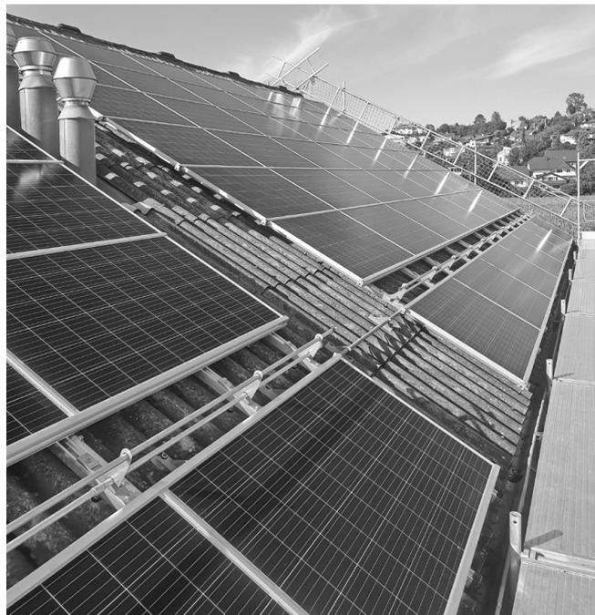
Die PV-Anlage mit einer Leistung von 100 kWp auf einem Giebedach mit einer Dachausrichtung Ost-West generiert vom Morgen früh bis am Abend spät ca. 83'000 kWh Strom pro Jahr. Das reicht für ca. 20 Haushalte. Mit dem Bau der Anlage wurde auch die Ölheizung durch eine Luft/Wasser-Wärmepumpenheizung ersetzt. Nun kann der produzierte Strom für das Gebäude und die Wärmepumpe direkt genutzt werden. Der überschüssige Strom wird ins Stromnetz von Eniwa eingespiessen und von Eniwa vergütet.
