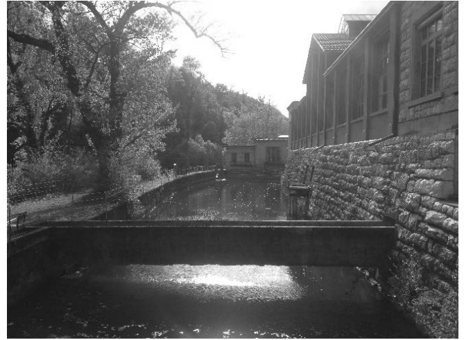
Hier steht das Wasser (Bild H. Kirrmann)
