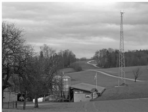
Bisher einzige netzgekoppelte Windkraftanlage im Aargau von 2009 mit 10 KW Leistung, Nütziweid/Schmiedruef
