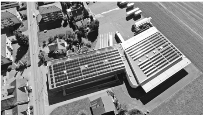
PV-Anlage bei der BM Transport AG in Unterkulm: 243 kWp, Baujahr 2020
