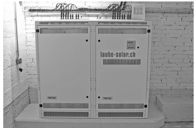
Einer der ersten Solarbatterien der Schweiz mit 28 kWh
