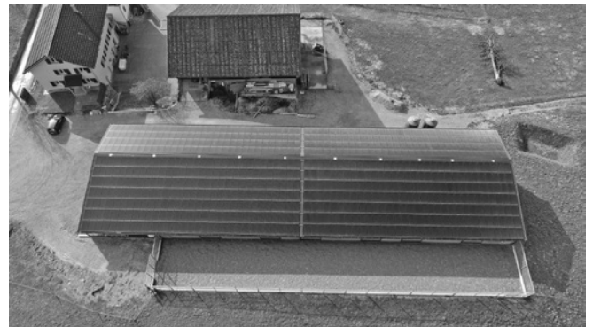
PV-Anlage auf Geflügelstall Feuz in Muri: 218 kWp, Baujahr 2020
