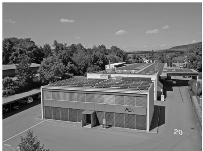
AEW Regional-Center Lenzburg mit PV-Anlage, Bild AEW
