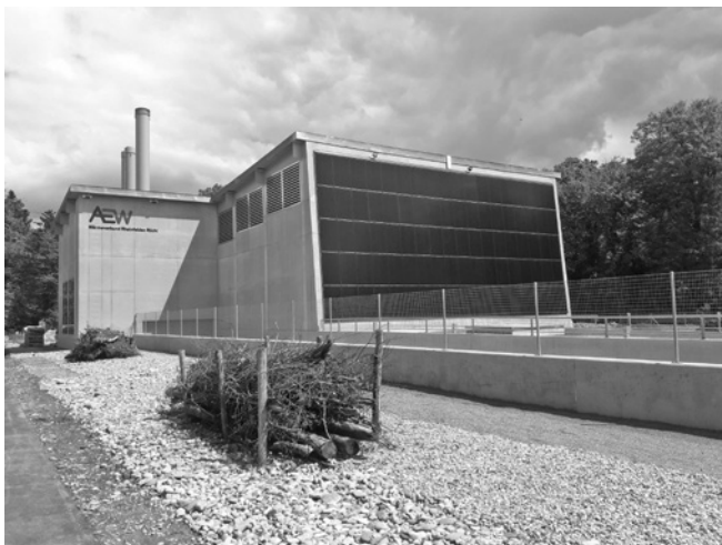
AEW Heizzentrale Wärmeverbund Rheinfelden Rüchi mit Solarfassade, Bild AEW
