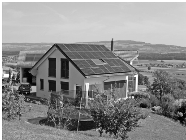
Schön gestaltete PV-Anlage, Bild Paul Müri
