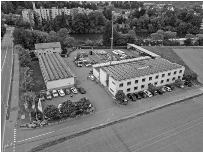
AEW Regional-Center Turgi mit PV-Dächern, Bild AEW
