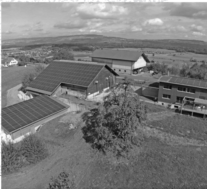
Landwirtschaftliche Gebäude werden in Zukunft noch viel mehr Solarstrom liefern (Betrieb Bernhard Koch, Kallern).
