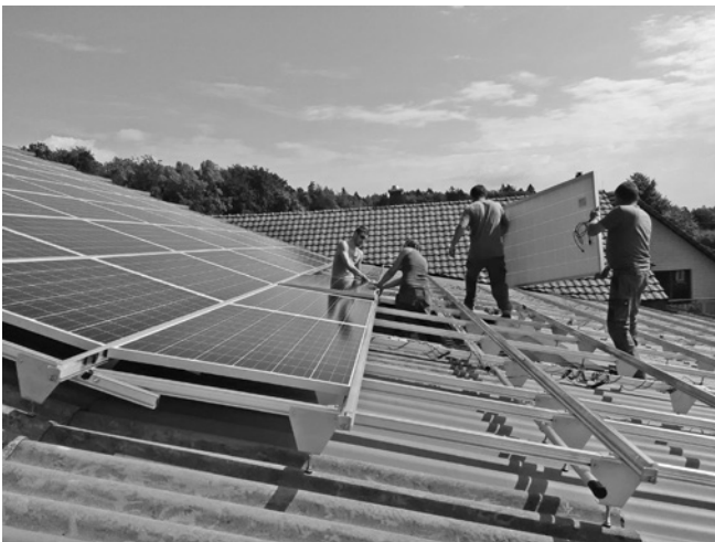
Montage der Panels 2016
