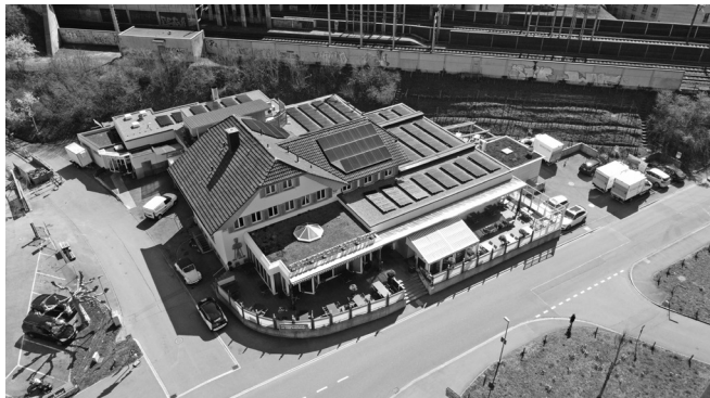
GV-Tagungsort Gasthof zum Schützen. Seit 2019 versorgt eine 57 kWp-starke PV-Anlage den Gasthof mit Solarstrom. Bild Eniwa AG
