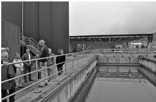
Besuch ARA Reinach mit Solar Faltdach
