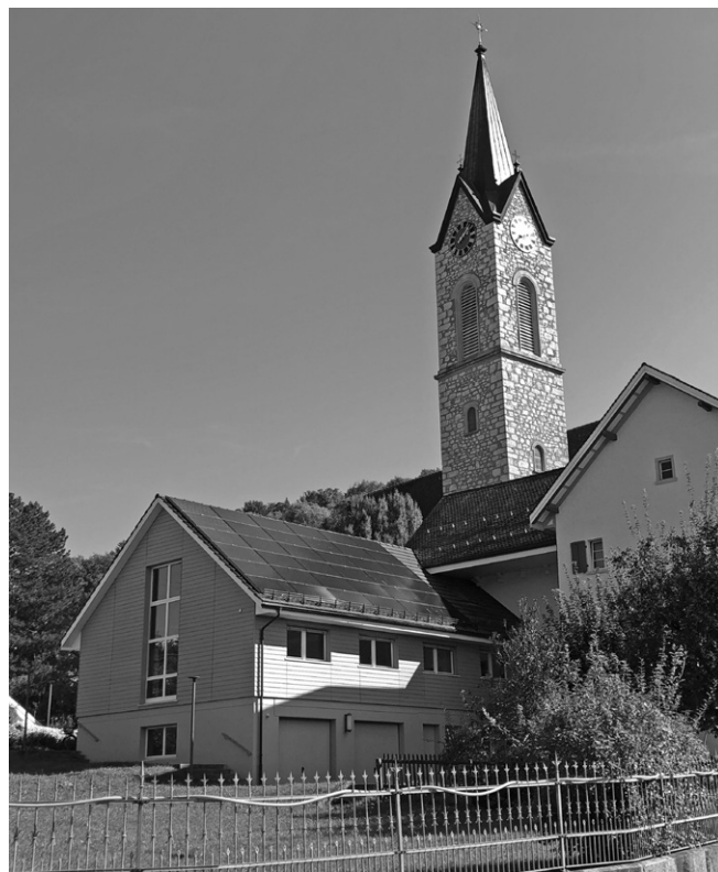
Kirche Unterendingen mit Pfarreisaal mit PV
