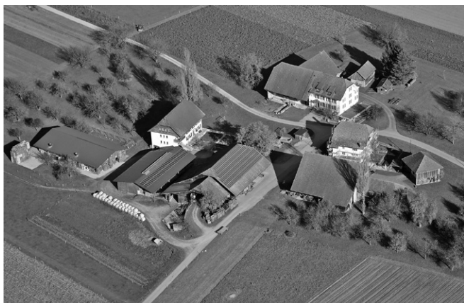
Mattenhof vor dem PV-Umbau - Bild Ruedi Hunziker Kölliken
