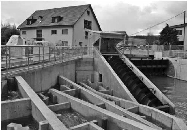
Das Lengnauer Wehr mit Fischtreppe und Wasserschnecke
