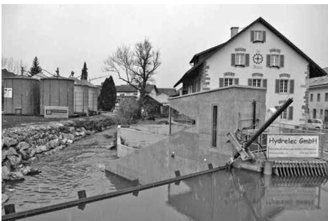
Das Wehr in Flussrichtung mit der historischen Mühle
