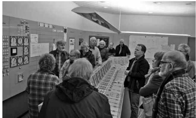
Hansjürg Tschannen erklärt die Steuerung des Kraftwerks
