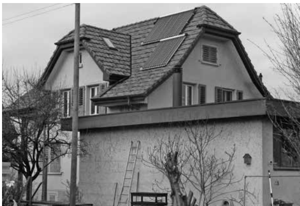
Röhrenkollektoren auf dem Haus Suter
