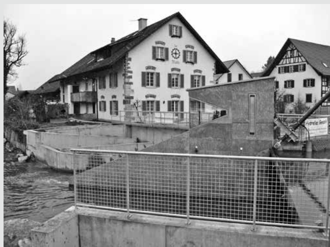
Das erneuerte Kleinwasserkraftwerk mit der Mühle im Hintergrund
