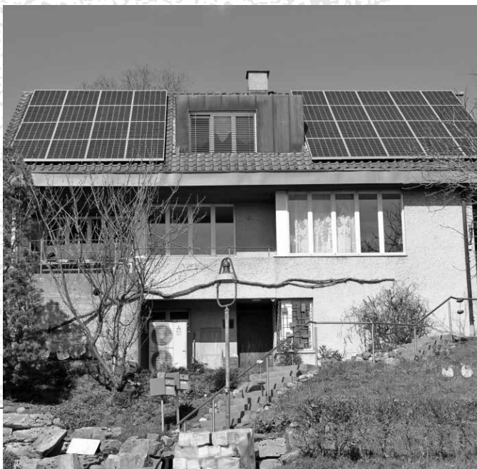
Haus Frei in Untersiggenthal mit PV 7.4 kWp, Wärmepumpe, Speicher 750 Liter
