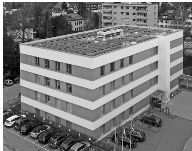
PV-Anlage auf dem Haus der Medizin in Brugg
