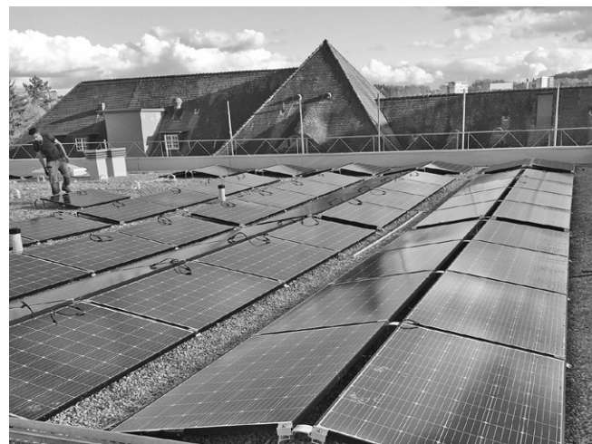
Installation der Anlage
