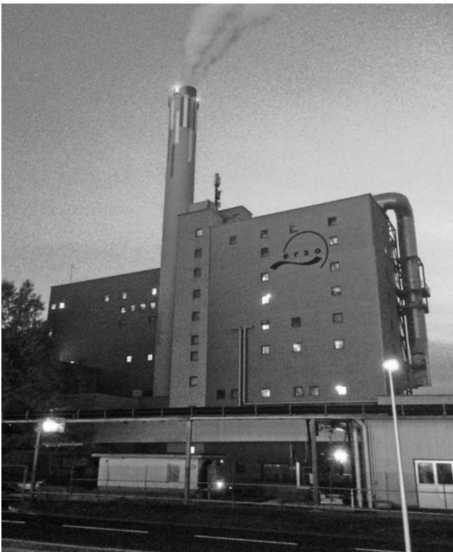
Energielieferant ERZO (Kehrichtverbrennung)
