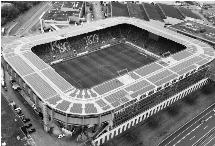
PV-Anlage auf dem Dach des Stadions.
