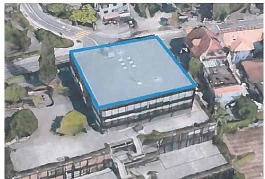
Emplacement de la centrale de 100 kWc
